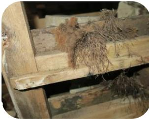
Ce champignon est souvent sous-estimé mais peut causer des dégâts structurels notables, notamment dans les caves et rez-de-chaussée. Le bois se décolore, se ramollit puis s'effrite. L'attaque peut rester longtemps inaperçue en raison de l'absence de fructification visible.
