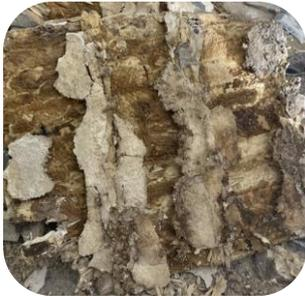
Ce polypore attaque le bois en profondeur et peut le rendre inutilisable en peu de temps. Invisible dans les premiers stades, il provoque une pourriture cubique, rendant les éléments porteurs cassants et dangereux. Sa propagation peut se faire à travers les maçonneries poreuses.
